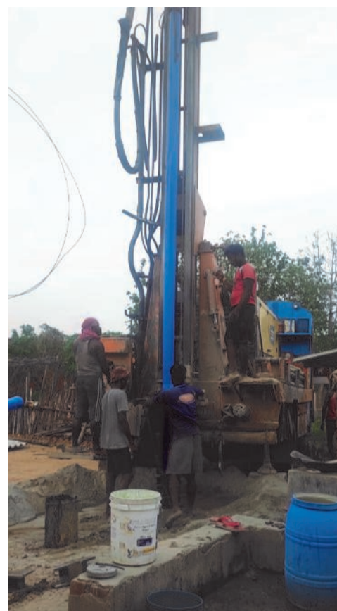
Die Dorfbewohner von Jaikudar beim Bau des neuen Brunnens
